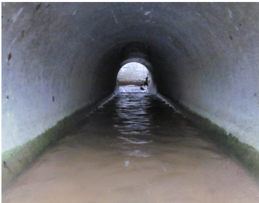
Foto 2: Vejbrønd/styrt set fra rørudløb
